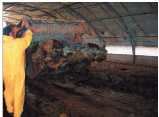
Figur 1: Eksempel på homogenisering af strøelse og brændt kalk ved brug af standardblandeudstyr (Ain – Frankrig)
